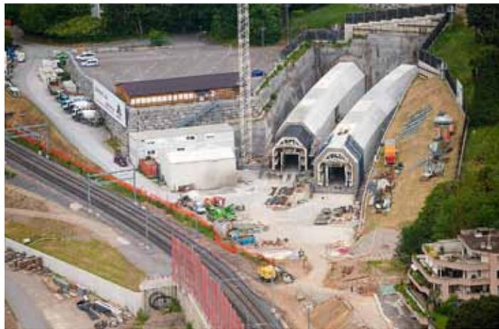
Mit dem Ceneri-Basistunnel, der Ende 2019 in Betrieb genommen wird, wird es nochmals zu einem Quantensprung kommen: Das im Bau befindliche Nordportal bei Lugano-Vezia mit der bestehenden Gotthard-Linie.
