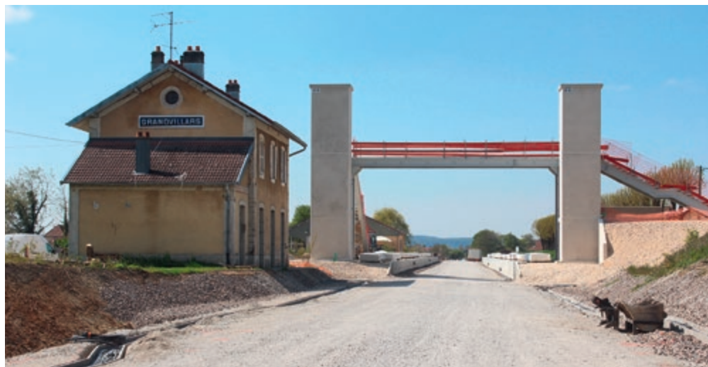
Baustelle am Bahnhof Grandvillars.
