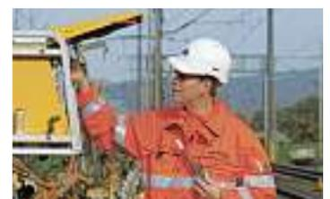
Am Morgen ist der Sicherheitswärter als erster auf der Baustelle. Hier schaltet er das automatische Warnsystem ein. Dieses unterstützt den Sicherheitswärter.
