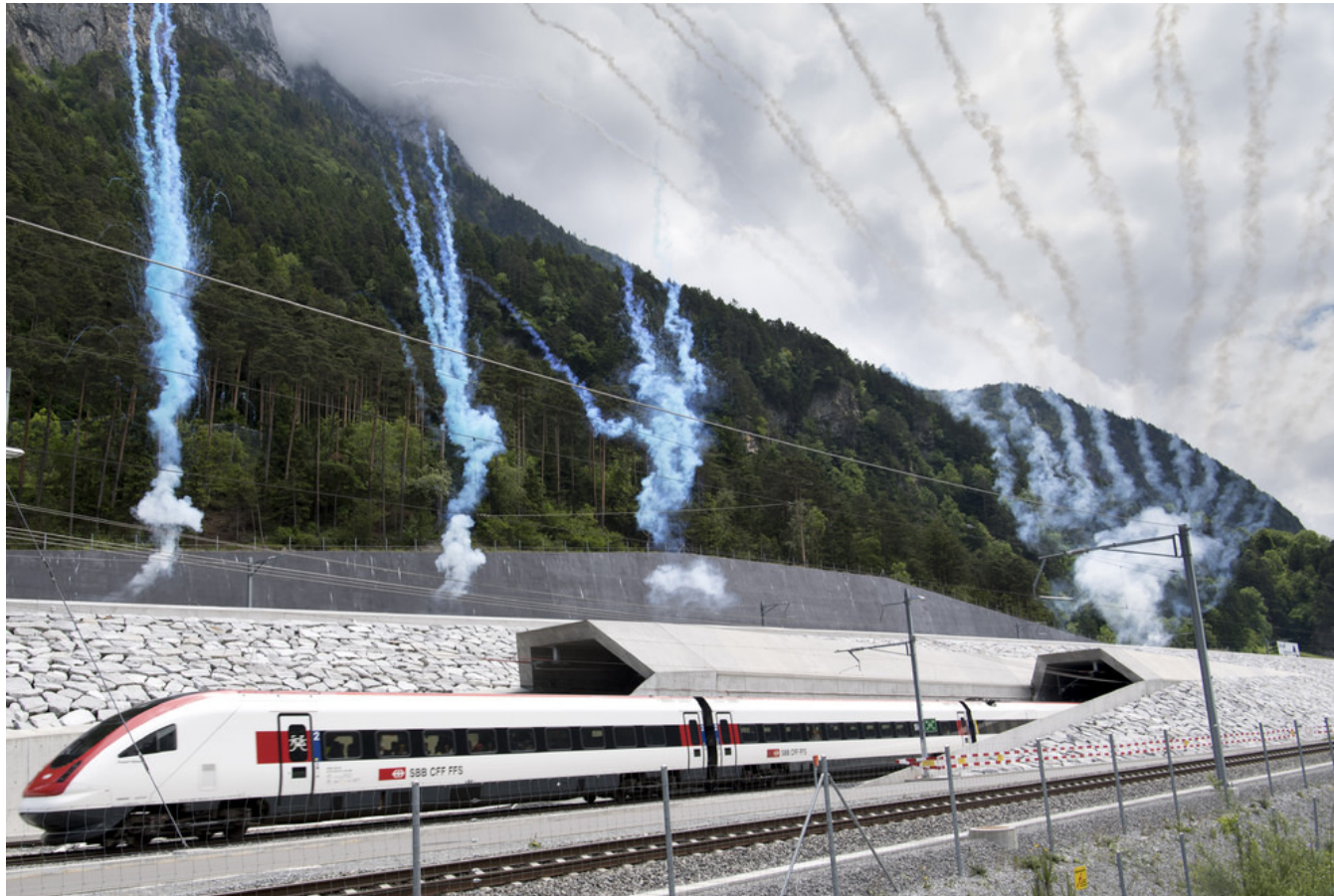
Eröffnungsanlass; erster Zug beim Nordportal in Erstfeld. Foto: Laurent Gillieron/Keystone
