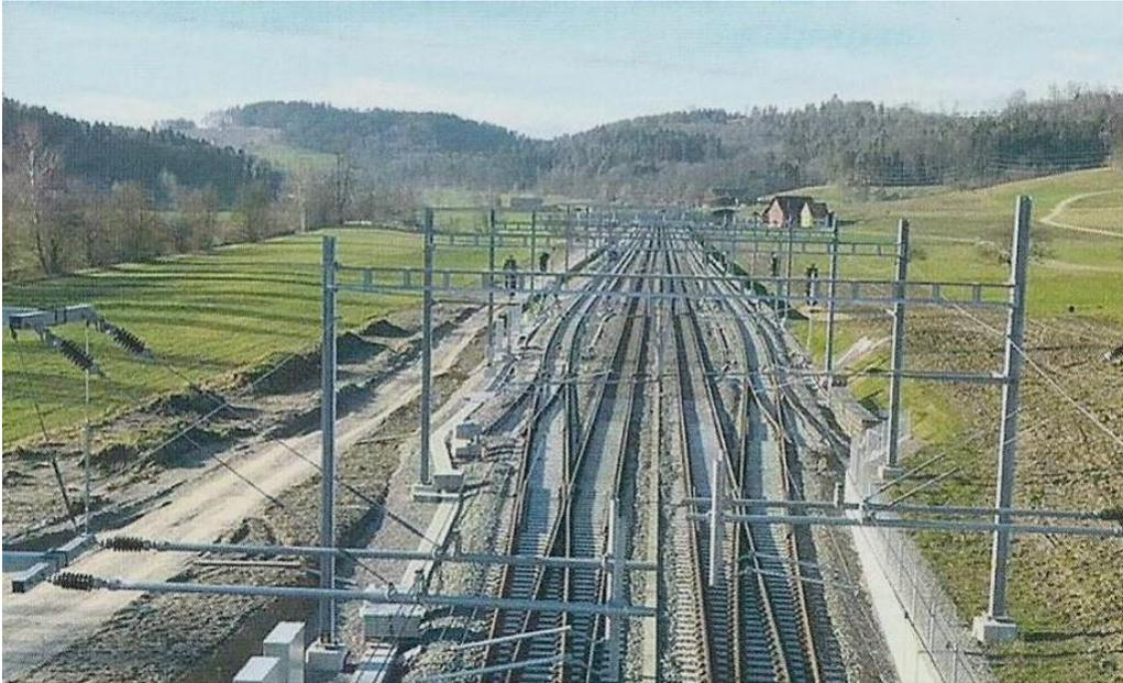
Bild: SBB; zwei neue 825 Meter lange Überholgleise Scheit bei Elgg
