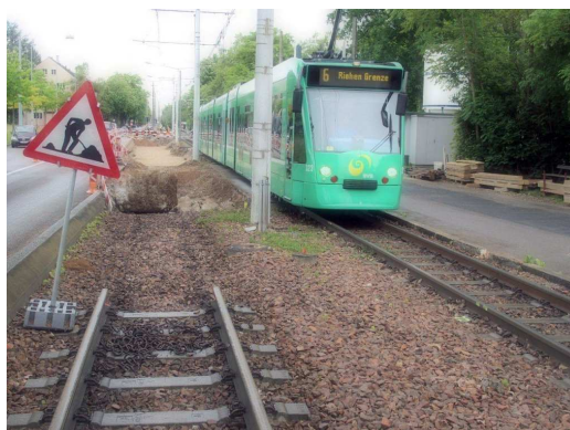
Sanierungsarbeiten im Bereich Schlaufe Eglisee
