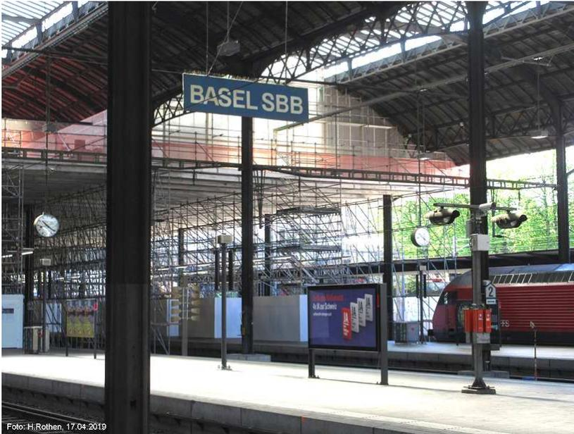
Baugerüst überspannt die Perrons und trägt die fussballfeldgrosse Arbeitsbühne auf 10 m Höhe
