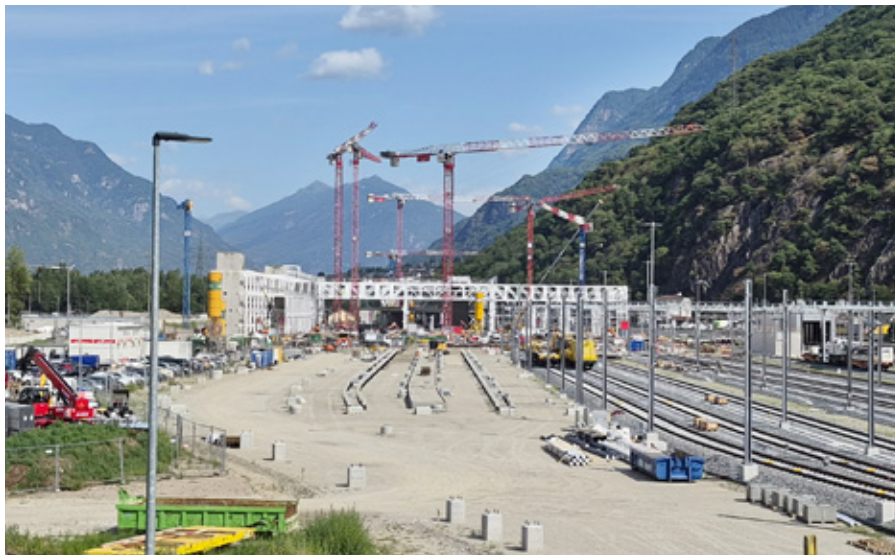
Gigantische Dimensionen: Das neue SBB-Werk «NSIF» für den Unterhalt von Triebzügen. Bild: Gerhard Lob
