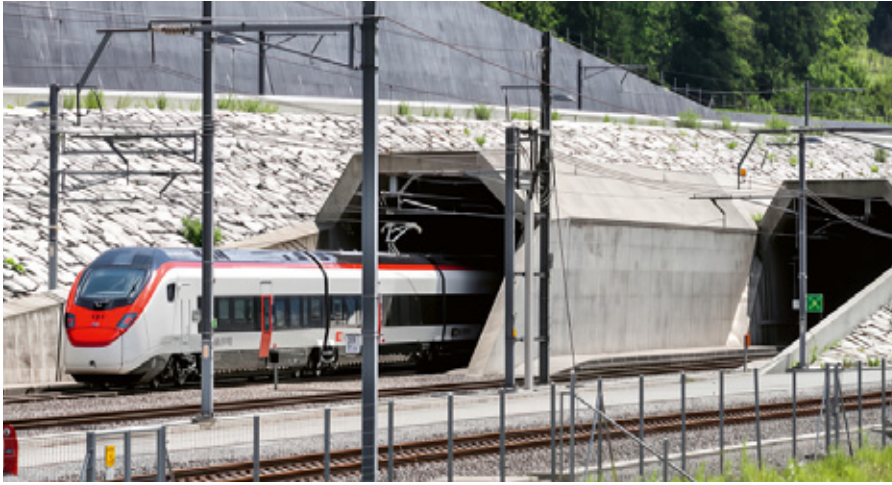
NEAT-Herzstück: Gotthard-Basistunnel zwischen Bodio und Erstfeld.
