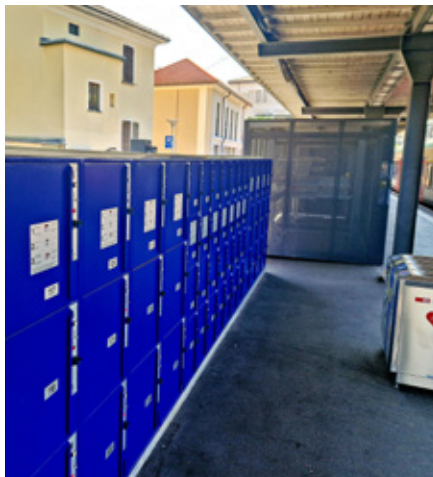
Kundenbedürfnis erfüllt: Neuinstallierte Fächer mit Schlüssel und Münzbezahlung. Bild: Gerhard Lob
