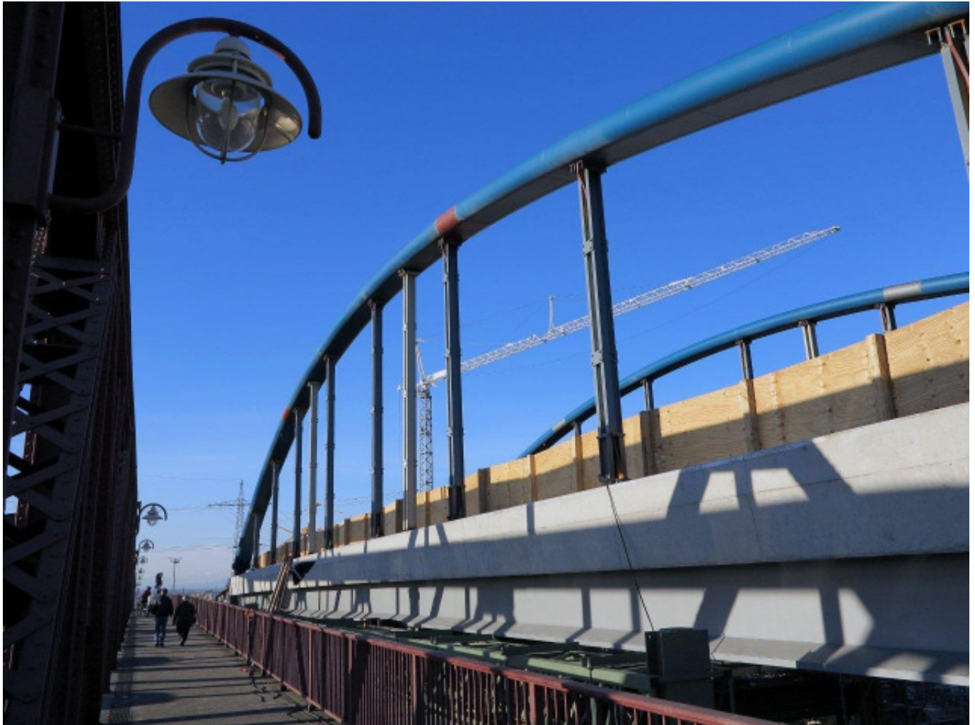
Trambrücke Weil am Rhein im Bau, Dezember 2013. Foto: André Guillaume
