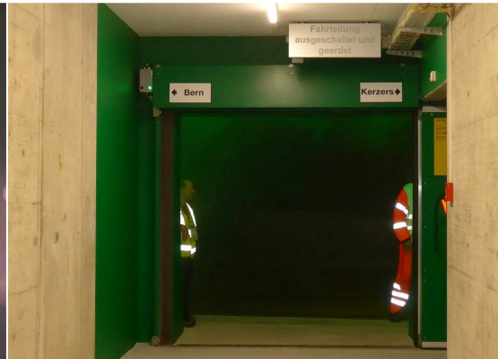
Anschriften beim Eingang Rettungsschacht - zu beachten: die Fahrleitung ist ausgeschaltet und geerdet
