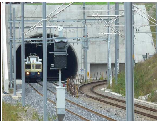
Der Tunnel ist eröffnet, der Blaue Pfeil kehrt als erster Zug aus dem Tunnel zurück
