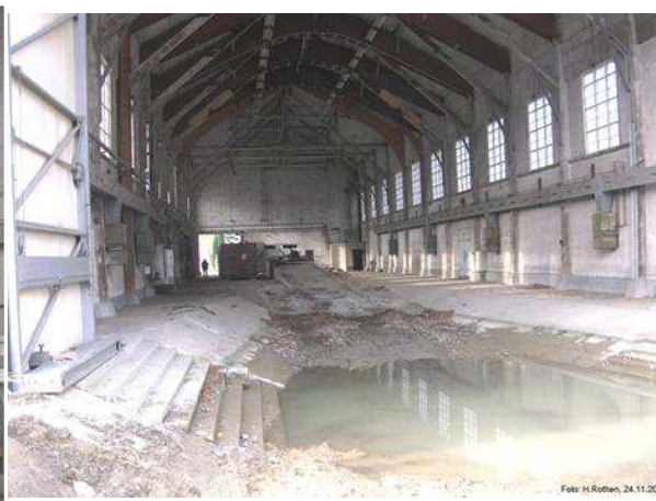
Werfthalle während Abbruch 24.11.2016
