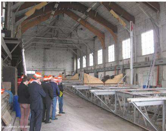
Werfthalle noch betriebsbereit 25.03.2015
